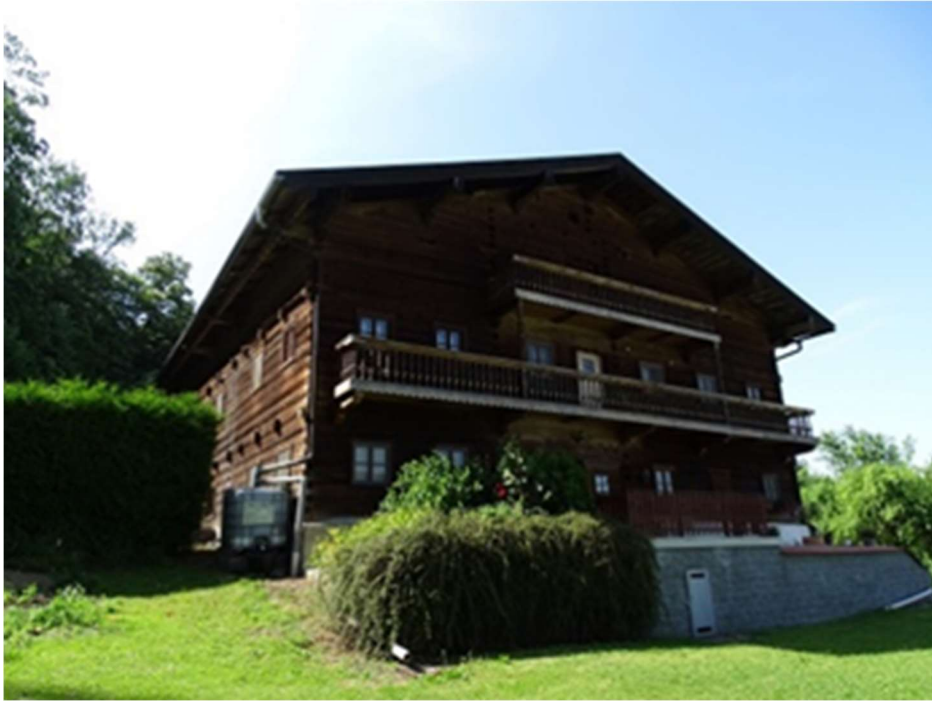
Bild 2: Ansicht des Holzhauses von der Balkonseite
