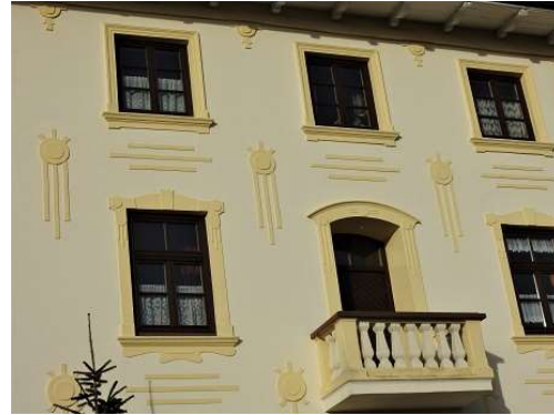
Abb. 6: Der Balkon als Fassadenschmuck
